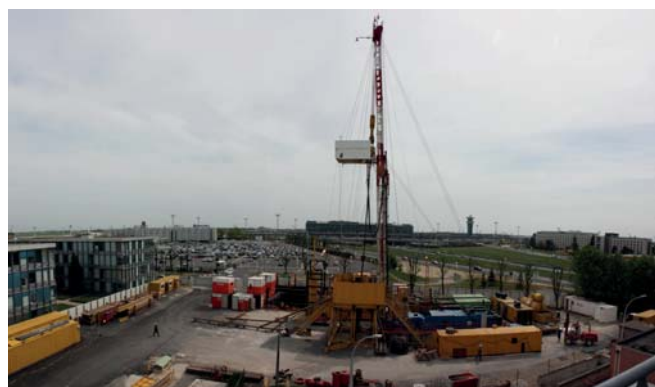
Chantier ADP en 2010 (Aéroport de Paris)
